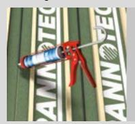
Le traitement des joints se fait par cordon continu de mastic, **Alsan Mastic 2200**, dans le chanfrein des panneaux.
