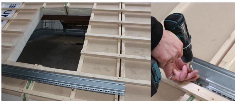
**1.** Visser les traverses horizontalement derrière le dernier liteau non découpé en bas et en haut de l'emplacement de la fenêtre.
