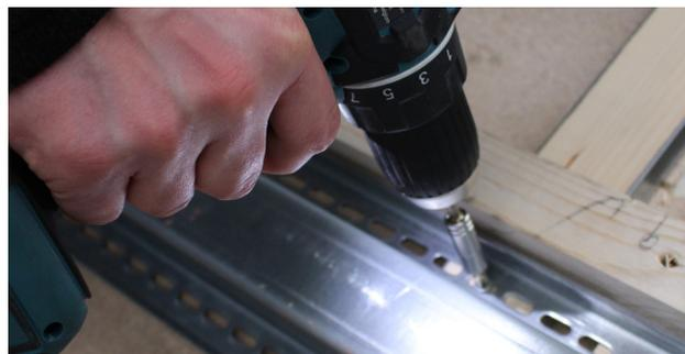
**2.** Disposer les montants verticalement sous les liteaux de part et d'autre du logement puis visser les montants aux traverses à raison de 2 vis à chaque angle.
