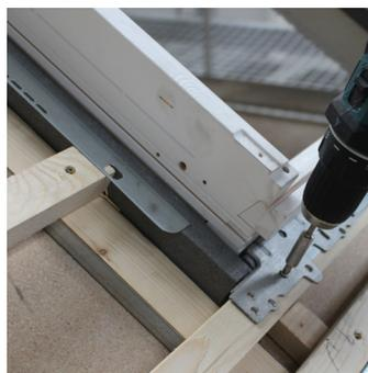
**4.** Fixer un liteau en partie haute et partie basse du logement permettant de visser les équerres de la fenêtre.
