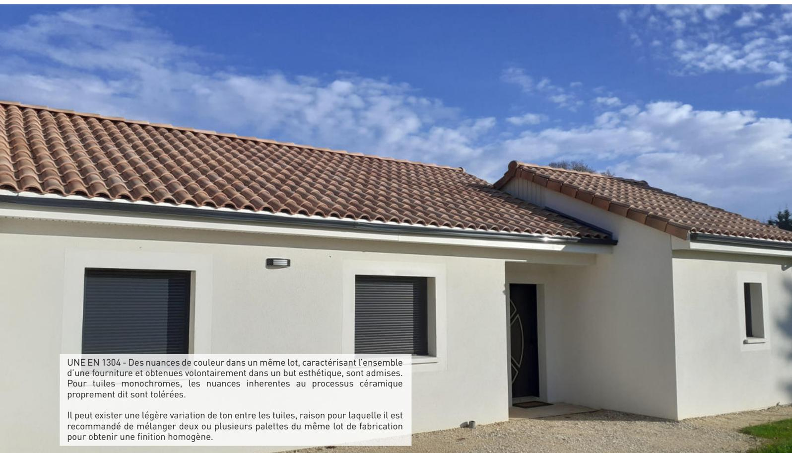
UNE EN 1304 - Des nuances de couleur dans un même lot, caractérisant l'ensemble d'une fourniture et obtenues volontairement dans un but esthétique, sont admises. Pour tuiles monochromes, les nuances inhérentes au processus céramique proprement dit sont tolérées.
