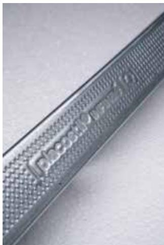
Montant Bas Carbone contenant 75% d'acier recyclé
