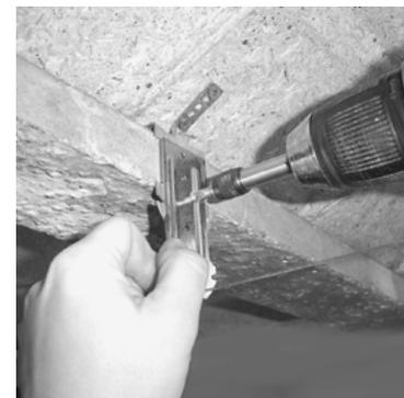
**3.** Si la hauteur de la suspente PHAR ne suffit pas, visser une suspente courte ou longue à l'aide d'une vis TRPF après réglage de la hauteur du plénum.
