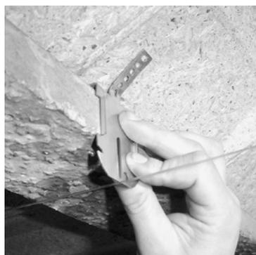
**1.** Positionner la suspente PHAR sur le talon de la poutrelle, et appliquer la languette en sous-face de l'entrevous.
