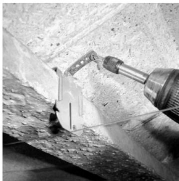
**2.** Fixer la suspente PHAR à l'entrevous à l'aide de 2 vis, en veillant à ce que les 2 ailes de maintien soient en appui sur le talon de la poutrelle.
