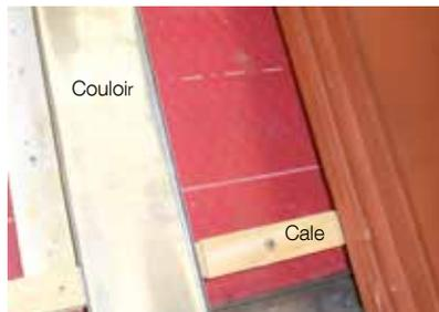
Mettre une cale sous la 3/4 de tuile pour l'ajuster à la hauteur de la tuile d'aération basse. Prolonger son emboîtement à la gouttière par un petit coulloir.
