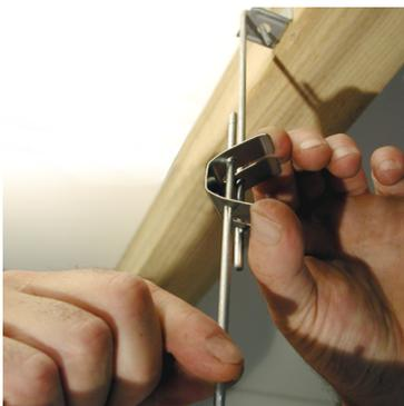
**1.** Ajuster la longueur des tiges lisses en appuyant sur le ressort.
