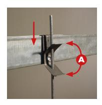
Clipser le grip vertical en le posant et l'enfonçant sur la tranche supérieure de l'ossature métallique.
