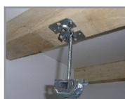
**Fixation en sous face du plancher béton ou bois**
