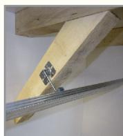
**Fixation sur la charpente bois en rampant**
