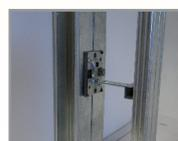
**Appui intermédiaire des cloisons thermiques pour les BBC**
