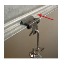
Clipser le grip horizontal en l'enfonçant sur la tranche de l'ossature métallique.
