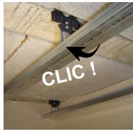
**3.** Clipser les fourrures SPP sur les suspentes PAI en engageant une aile dans la fente horizontale puis faire pivoter jusqu'au CLIC.
