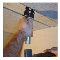
Positionnerlasuspenteentre la poutrelle et le hourdis béton, griffes côté hourdis.
